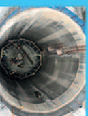
پوشش بتنی شفت (مبله) آبگیر اصلی سد اردبیل
