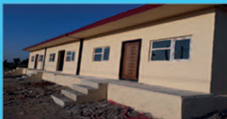
ساختمان پیش ساخته بتنی سریع الاجادات موسسه شهید رجایی
