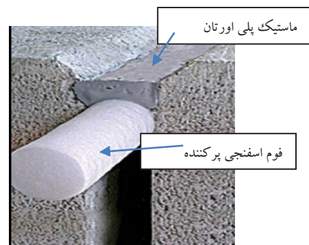
شکل ۶: درز بندی عمومی ژوئن های حرارتی (انبساطی)
