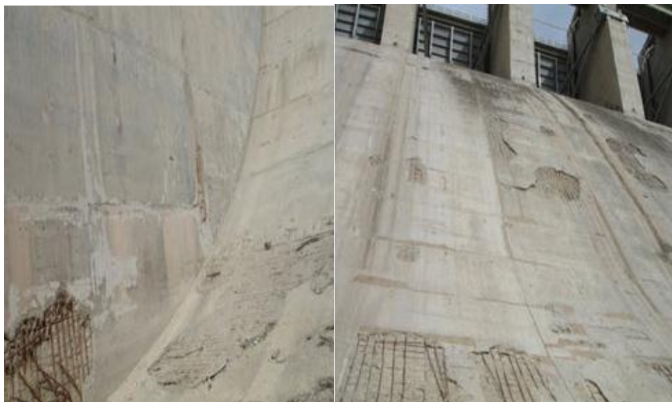
شکل ۷- خرابی بتن سد استقلال میناب
