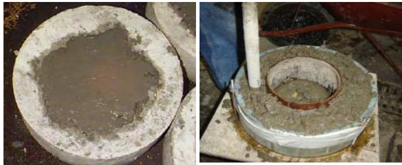
شکل ۵- اجرای ملات‌های ترمیمی بر روی بتن پایه
