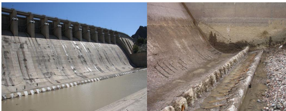
شکل ۷- خرابی ناشی از سایش در سرریز سد
