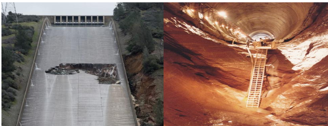
شکل ۱- نمونه‌های خسارت ناشی از کاویتاسیون در سازه هیدرولیکی
